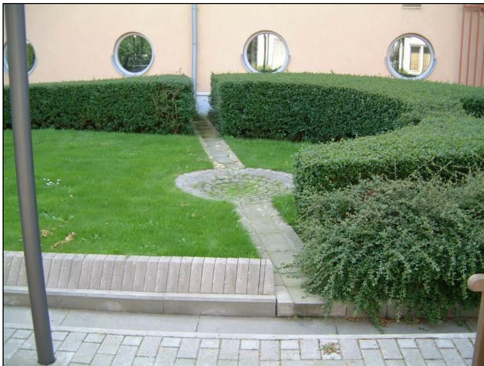
Figur 10. Exempel på rännalsplattor (Foto: Norconsult)
