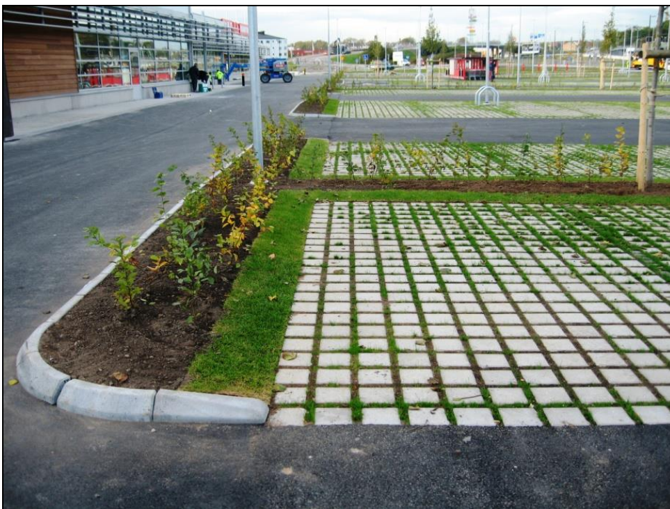
Figur 12. Exempel på permeabel beläggning (Foto: Norconsult)
