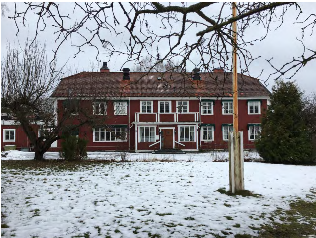
Bild 5. Det tidigare gästgiveriet vilket uppfördes år 1929.
