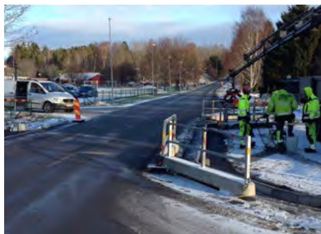
Trafiksäkerhetshöjande åtgärder vid Futurumskolan.
